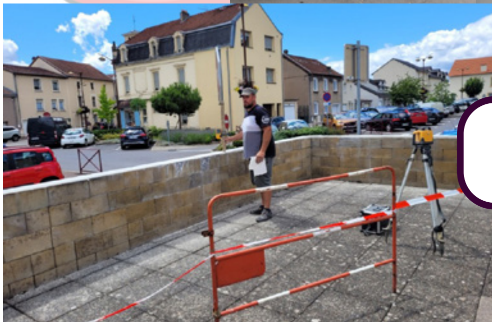
Remplacement couverture Place Chanoine Colin
